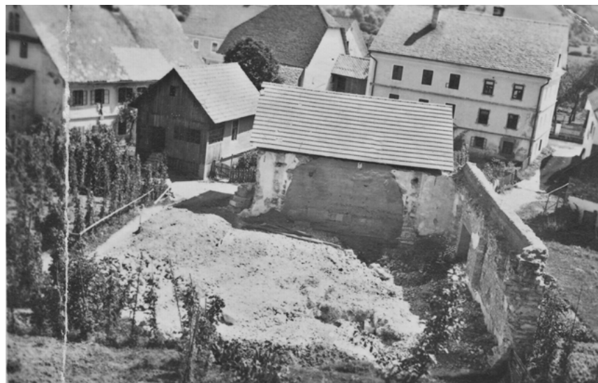
Slika 29. Rušenje cerkve v začetku tridesetih let 20. stoletja. Od cerkvena ladje stoji samo še desna stena. Levo in desno od slavoločne odprtine je v ometu vidno mesto dveh porušanih stopenj, ki sta bila prizidana pri izgradnji obokov v začetku 18. stoletja. / Hrani Ida Oblak
