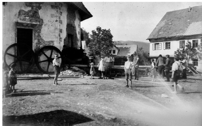
Slika 25. Skozi porušeno zadnjo steno prezbiterija spravljajo parni stroj. / Fototeka Muzeja Žiri
