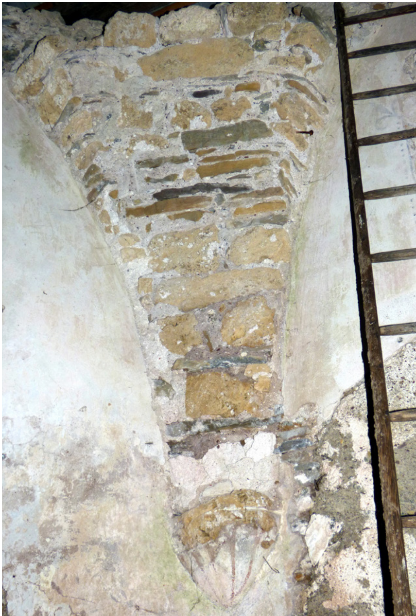
Slika 7. Ohranjen spodnji del oboka v prezbitoriju s poslikano konzolo vsebuje veliko lehnjaka. / Foto Jure Ferlan, oktober 2024
