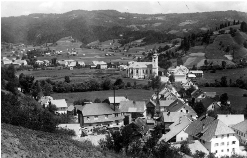
Slika 26. Cerkev degradirana v žago, leta 1927 ali v naslednjih dveh ali treh letih. Dimnik parnega stroja stoji na levi strani prezbiterija, njegovo podnožje so arheologi izkopali v prezbiteriju. / Fototeka Muzeja Žiri
